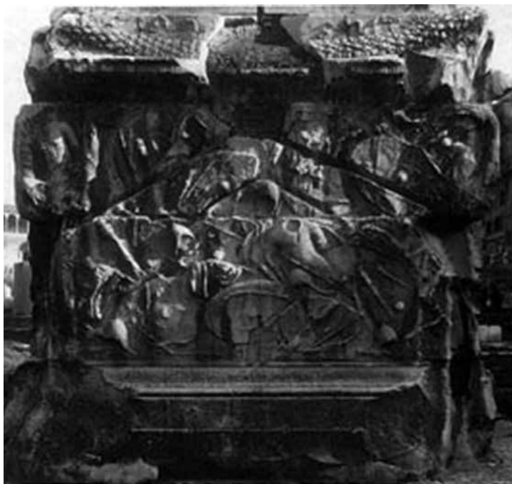
Figura 2: Colonna Traiana, facciata settentrionale del basamento, in cui sono evidenti i segni dell'incasso di un tetto a falde.
