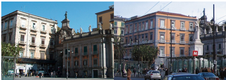
Fig. 9 – Indagine/intervento: piazza Dante 22, quartiere Avvocata
