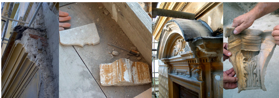
Fig. 5 – Indagine/intervento: via Tasso 9A, quartiere Chiaia
