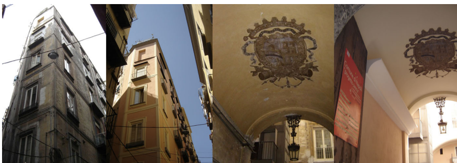
Fig. 6 – Indagine/intervento: via Pasquale Scura 8, quartiere Montecalvario
