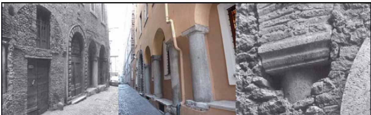
Fig. 12: via della Tribuna di Campitelli; raffronto riprese 9 fine anni '80 con riprese del 2013.
